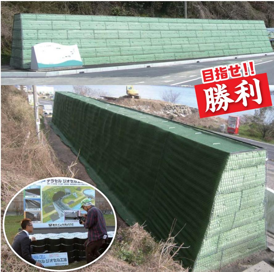
RGB工法は【テラセル®】【トレップ®】【AZ型枠】を使用した補強土壁を構築し、落石から保全対象物を防護する工法です。
