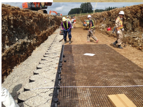
施工規模 グラウンドセル GG-200M 施工延長：L=122m 法面勾配：1：0.3
