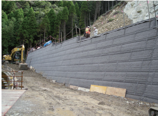
◀ 施工前状況 ▼ 施工状況
