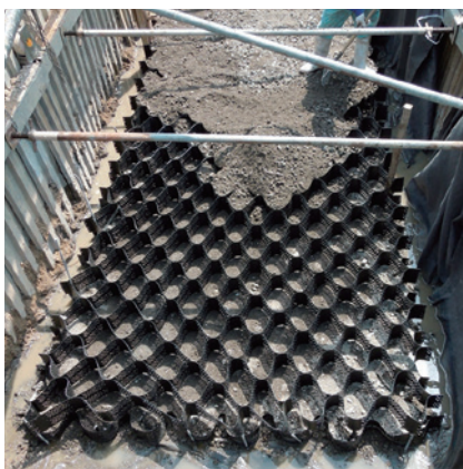
施工時 工事名：経営体育成基盤整備事業 概要：T-150MP×2段
