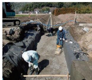
3 中詰材敷均し・締固め
