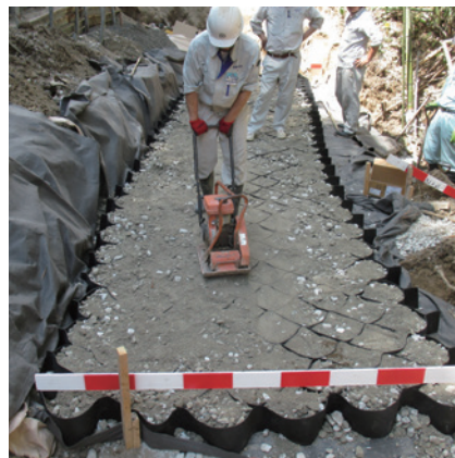
施主：新潟県佐渡市役所 工事名：市道浜中1号線 概要：T-150MP×2段
