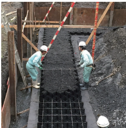
施主：熊本県芦北町役場 工事名：第4分団消防ポンプ格納庫新築工事 概要：T-150MP×2段
