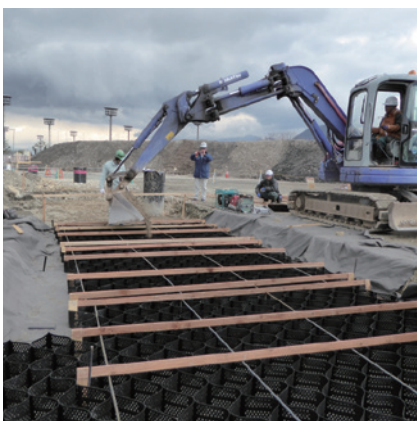
施主：山形県山形市役所 工事名：山形市新野球場建設建築工事 概要：T-150MP×2段
