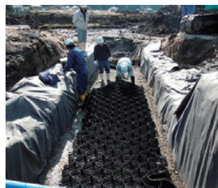
2 不織布(吸出し防止材)・テラセル設置
