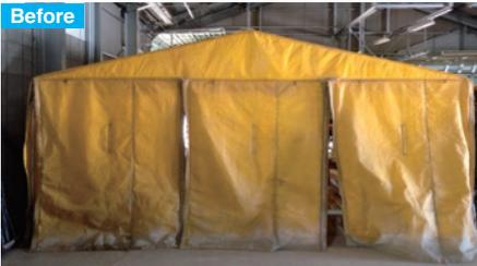
既製被覆材（PEクロス／樹脂綿／PEクロス複合）
