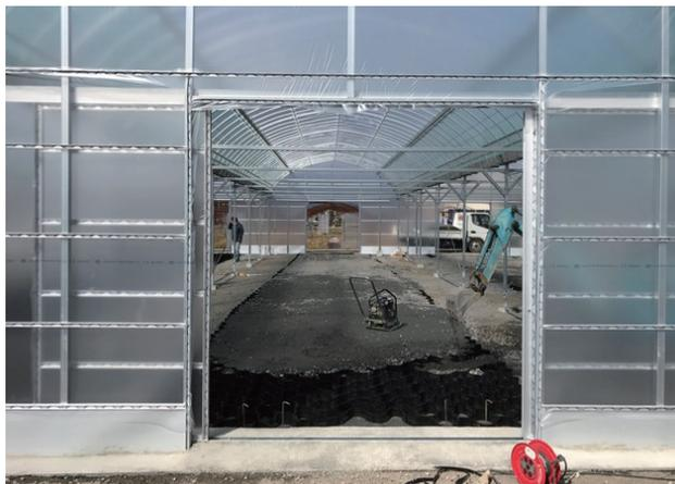
※仕上がりの出来不出来を大きく左右する締め固め転圧は、小型転圧機を使用し、原地盤もしっかり転圧。
