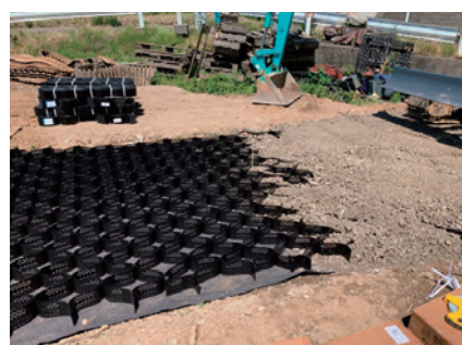
② 碎石（0mm～40mmのもの）を充填＊碎石充填後はすぐに通行出来ます。ハウス内全面敷設
