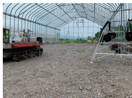
③ 碎石充填後、転圧
