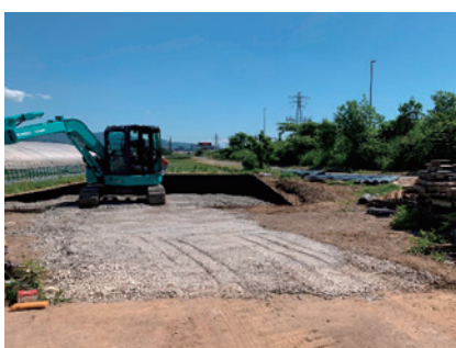
② 碎石（0mm～40mmのもの）を充填＊碎石充填後はすぐに通行出来ます。ハウス内全面敷設
