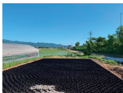
② 碎石（0mm～40mmのもの）を充填＊碎石充填後はすぐに通行出来ます。ハウス内全面敷設
