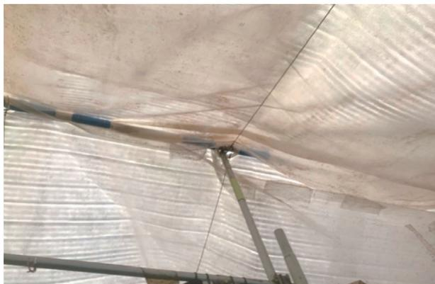
天井部からの熱の流出を防ぐために、パッカーとPO補修テープを使用し隙間を少なく施工されています。今回生産者の方が、施工されましたが天井の施工に関しては3人以上の人手で行った方が施工しやすいとのことでした。
