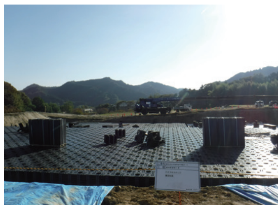
プラスチック製地下貯留浸透施設施工状況
