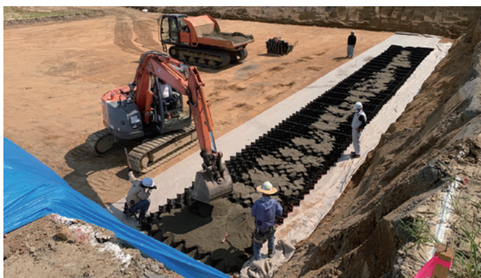
グランドセルマットレス工法施工状況
