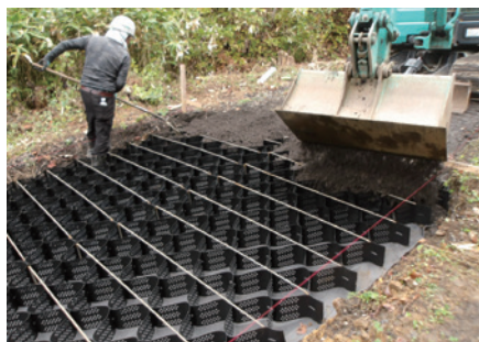
グランドセル施工状況
