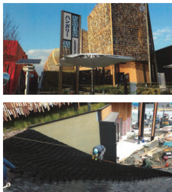
プラスチック製地下貯留浸透施設施工状況
