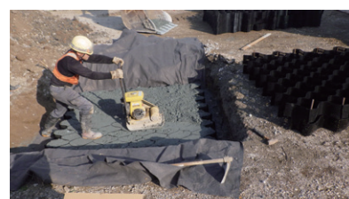
グランドセル施工状況
