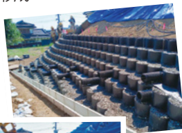
テラセル 施工状況
