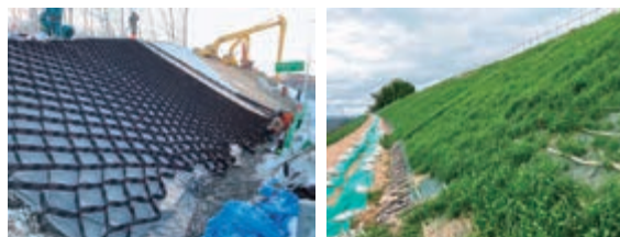
のり面施工状況
