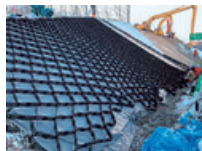
のり面施工状況
