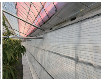
下：左) 補強パイプ部分の施工 右) ハウスサイドカーテン固定張り
