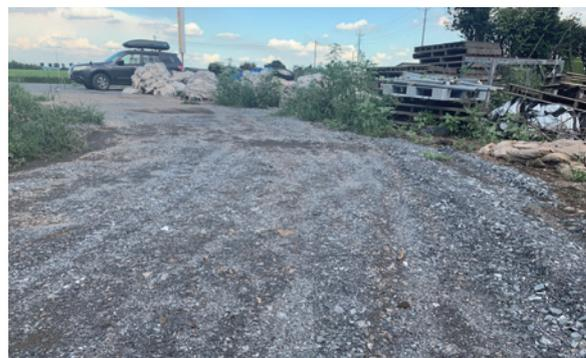
今回、大畠社長自ら小型重機にて掘削から碎石の撒き出し・転圧まで行って頂きました。簡単に施工することができ、施工後すぐに通行可能であるため、工期短縮が可能です。また、上記写真のような曲線を描いた施工箇所でもグランドセルの特長を生かし柔軟に対応することができます。
