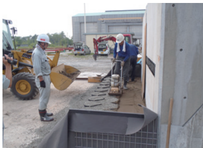
② 中詰材投入・転圧 (下段)
