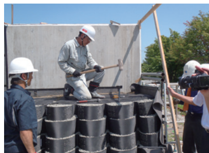
⑥ 鉄筋アンカー打設
