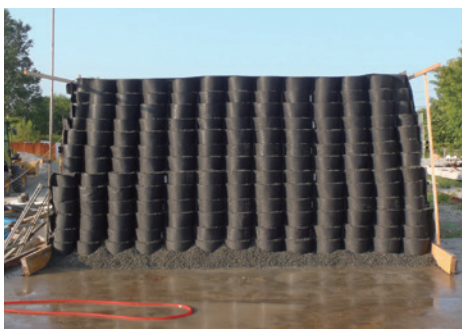
GIB 工法出来形写真
