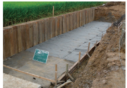
7 吸出し防止材を折り返し、施工完了
