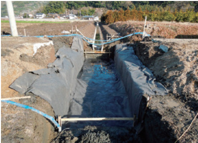
2 吸出し防止材の敷設
