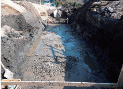
1 掘削・床付け
