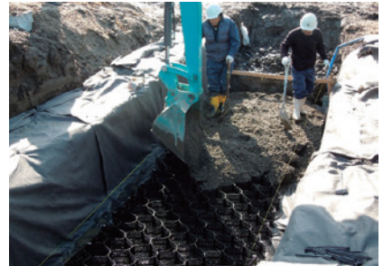
4 中詰材(碎石)の充填
