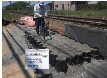
2. 中詰材充填・転圧
