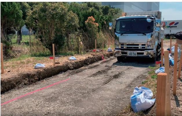
2020年4月に弊社羽生工場にてグランドセル路盤補強工法の実物大実験を実施しました。今回の実験では、グランドセルで補強したケース1～3と碎石のみを敷設した無補強のケース4による路盤上に、7t車のダンプを1150周走行させ、工法による効果の確認を行いました。
