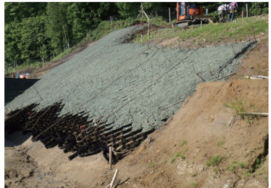
1 段目砂利投入状況
