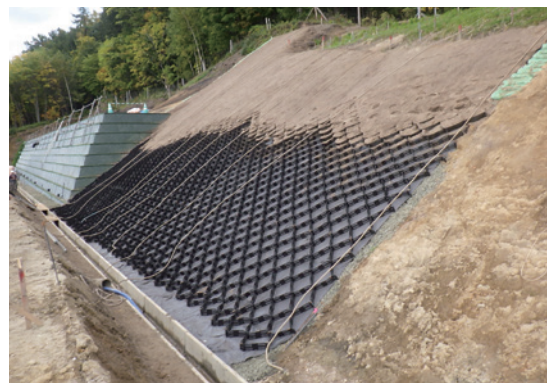
2 段目覆土状況
