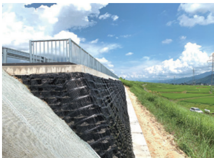
非常駐車帯④ 施工後
