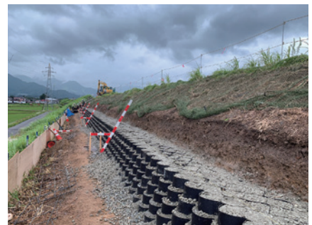
非常駐車帯② 施工中・施工後
