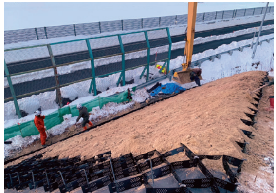
グランドセル発生土充填状況
