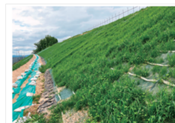
完成後緑化状況
