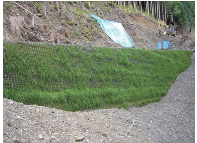
工事名：林道 日和茶坂瀬線 発注者：徳島県西部総合県民局 施工場所：徳島県三好市
