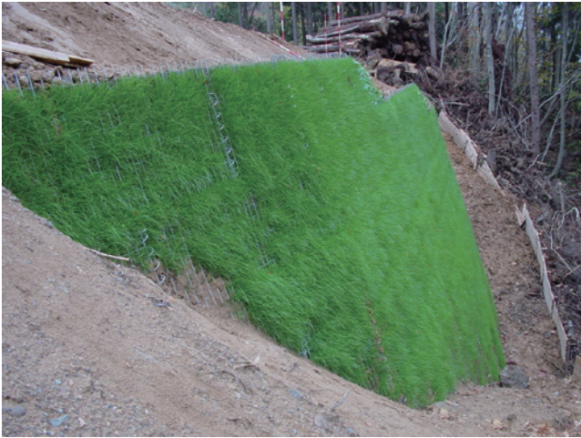
工事名：林道 三川線 森林基幹道開設事業 発注者：兵庫県但馬高原林道建設事務所 施工場所：兵庫県見方郡香美町
