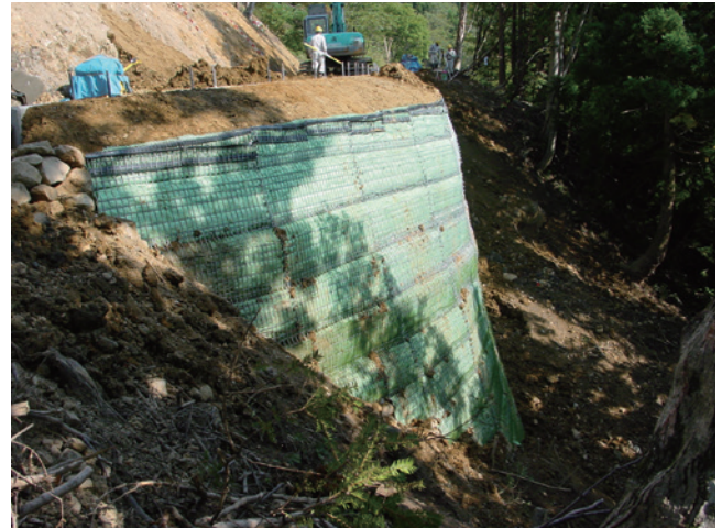
工事名：林道 駒ヶ岳線 流域公益保全林整備事業 発注者：糸魚川市役所農林水産課 施工場所：新潟県糸魚川市
