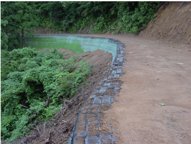
工事名：林道 俎山線 里山エリア再生交付金事業 発注者：糸魚川市役所農林水産課 施工場所：新潟県糸魚川市
