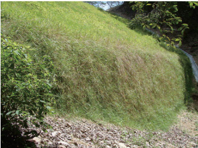
工事名：林道 本田下線第2工区 発注者：邑南町役場 施工場所：島根県邑智郡邑南町
