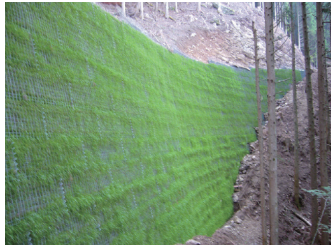
工事名：林道 生見八重地線 発注者：徳島県農林事務所 施工場所：徳島県勝浦郡上勝町
