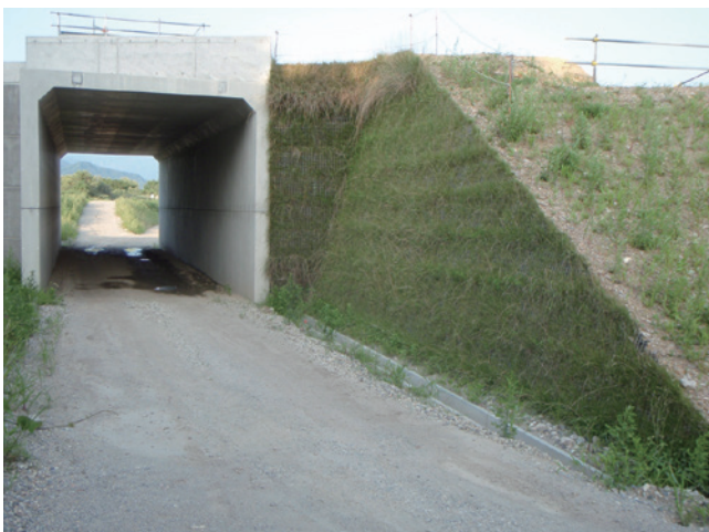
工事名：日本海沿岸東北自動車道 高根橋下部その1工事 発注者：国土交通省 北陸地方整備局 羽越河川国道事務所 施工場所：新潟県村上市
