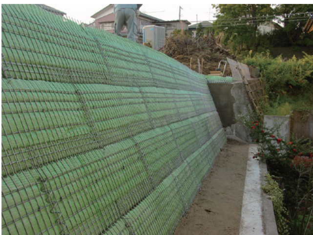
工事名：寺尾土留工事 発注者：民間 施工場所：新潟県新潟市
