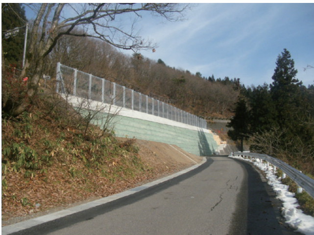
工事名：八木山耐雪帯整備工事 発注者：国土交通省 北陸地方整備局 新潟国道工事 施工場所：新潟県阿賀町
