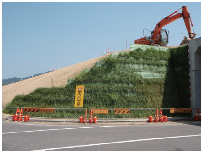
工事名：荒川道路その22工事 発注者：国土交通省 北陸地方整備局 羽越河川国道事務所 施工場所：新潟県村上市
