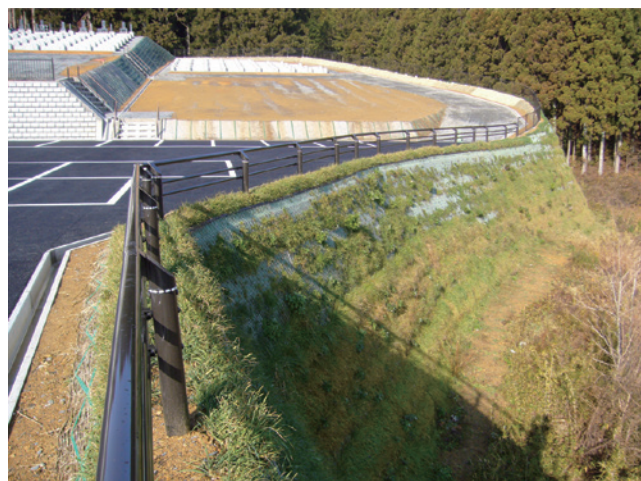
工事名：大雄寺墓地造成工事 発注者：民間 施工場所：宮城県本吉郡南三陸町
