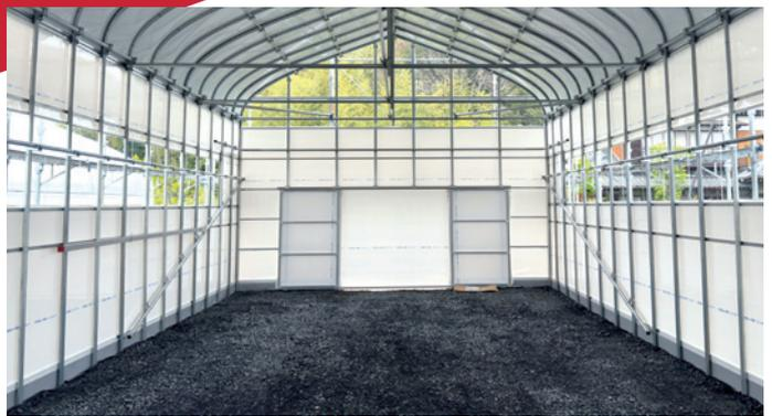
3 充填した中詰材(碎石)を転圧し施工完了
