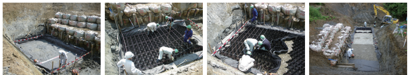
1 吸出防止材設置
