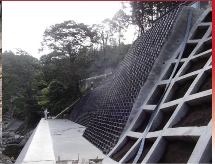
セル状壁面工のテラセル®とジョグリッドを用い、壁面工および補強材、盛土材料が相互に拘束し一体となって挙動することで、一つの土構造物としての安定を図る工法です。
