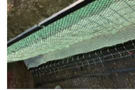
植生シート設置
