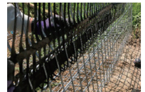
天端用補強材取付
