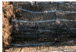
裏面部補強材連結状況
