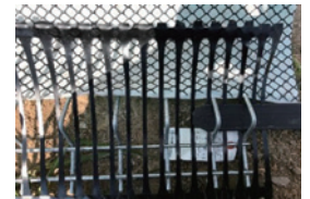
型枠補助材接続
