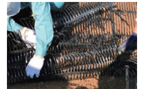
裏面部補強材連結
