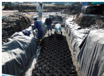
2 不織布(吸出し防止材)・グランドセル設置
