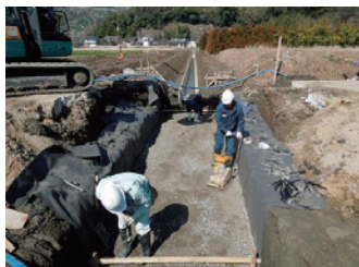
3 中詰材敷均し・締め固め
