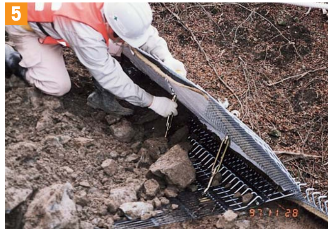
天端部 FW-AB 枠 (FW-AB 枠で天端部のみ斜体材 (ターンバックル) 調整)
