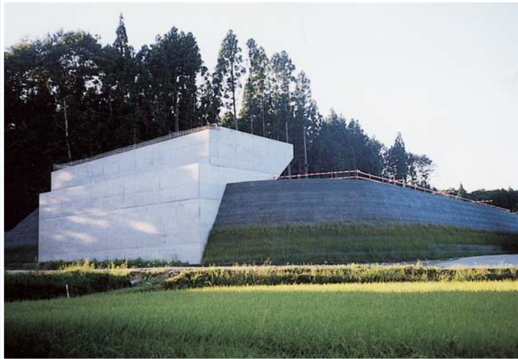
<日 290 号沢田川橋取付工事>
