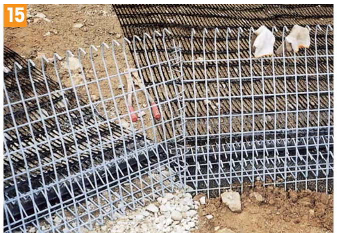
15 角曲げ施工〔FW 枠底板部カット及び接続コイルによる角度のある法面施工〕
