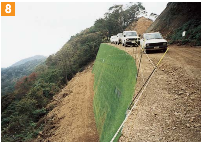
FW 工法施工後植生状況
