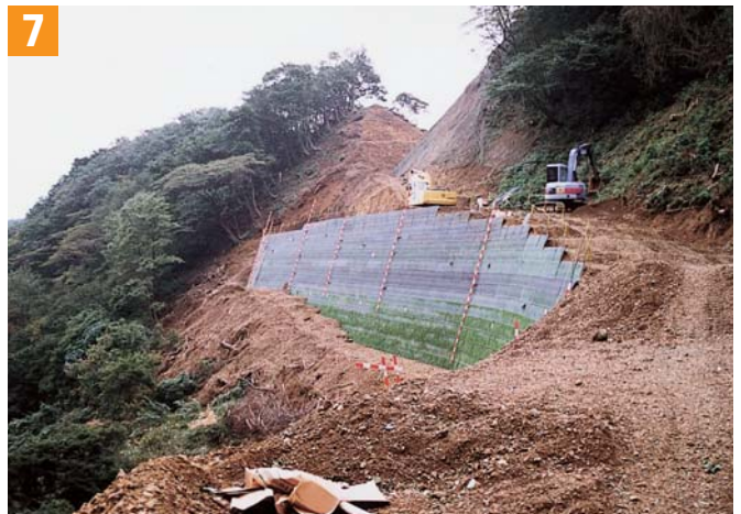
7 FW 枠施工中
