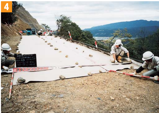
排水材敷設 [タフネル]
