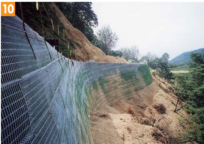
10 天端部盛土傾斜処理〔盛土傾斜に沿ってFW 枠をカットし法面を仕上げる〕
