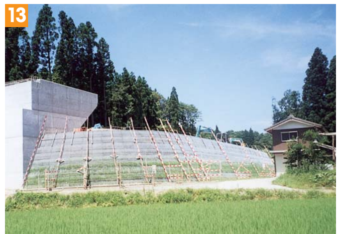
外アール施工 [アバット部施工]
