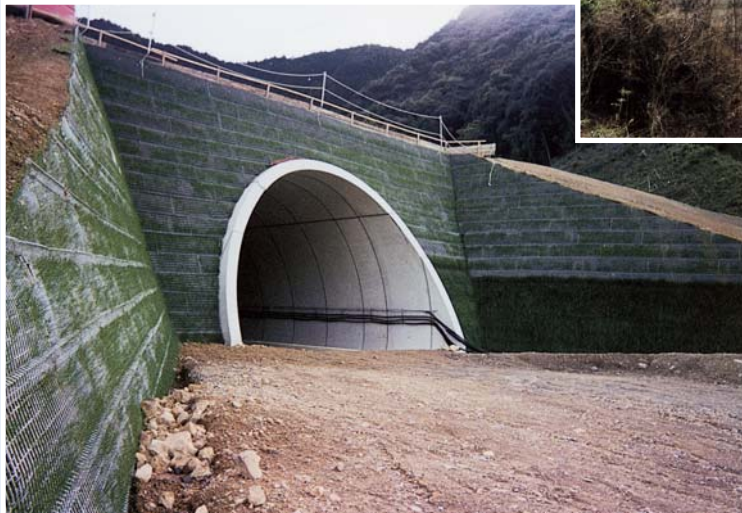
<第 2 東名高速道路 藤枝第 1 トンネル工事>
