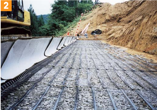
2 テンサー敷設／ネットロンシート・植生マットセット
