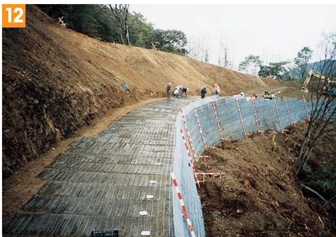
内アール施工
