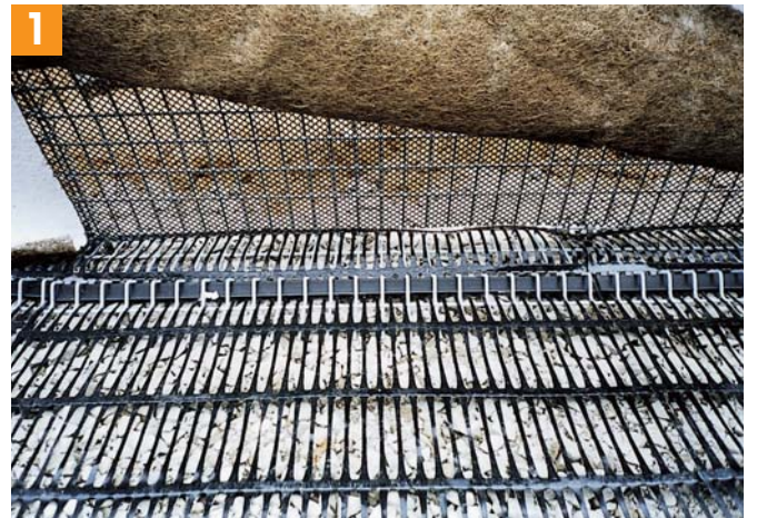
FW-A 枠とテンサーをテンサージョイナーで接続
