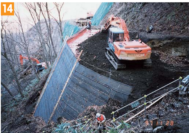
14 角曲げ施工〔FW 枠底板部カット及び接続コイルによる角度のある法面施工〕
