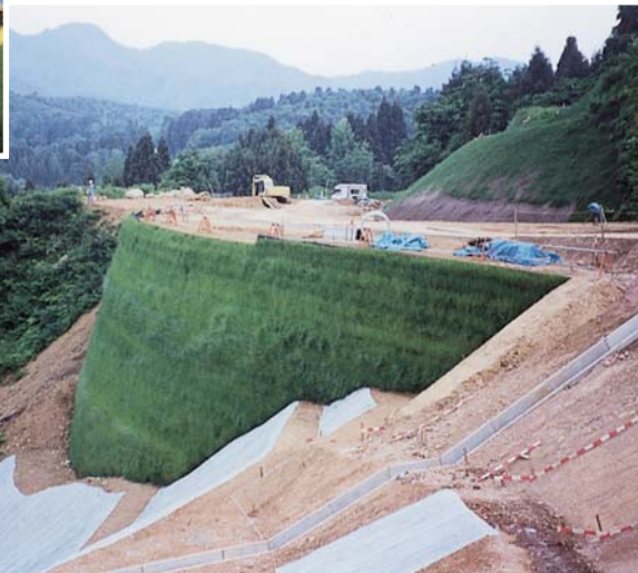
<鵜川治水ダム 2 号 (原石山) 工事用道路>
