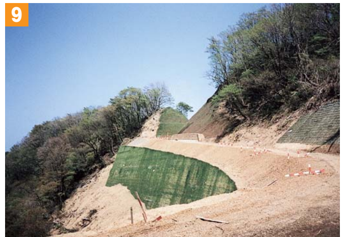
FW 工法施工完成
