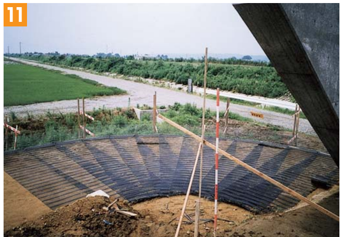
11 外アール施工
