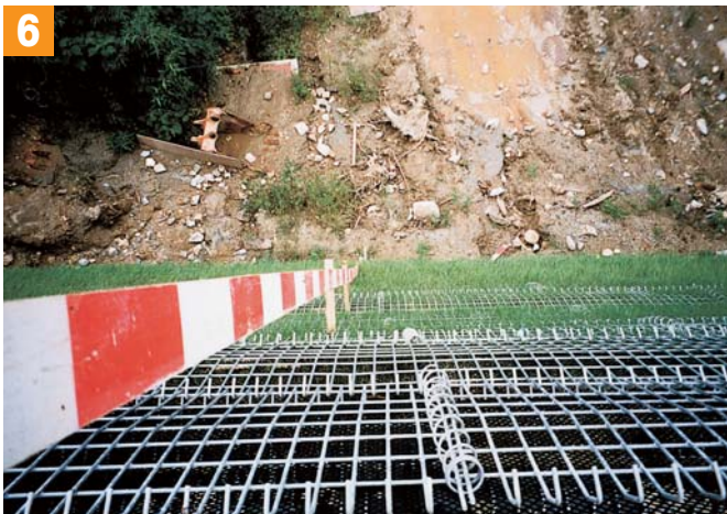
6 FW 枠の接続〔枠と枠を連結コイルで接続〕
